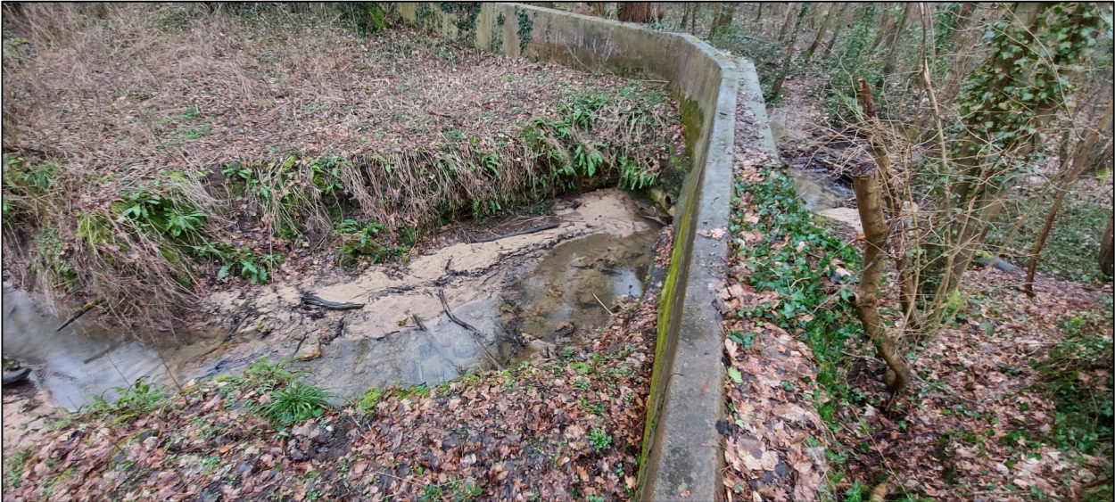
Vue du ru d'Angoulême en sortie du bassin existant (vue amont)
